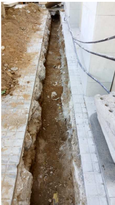
Foto3, vista de la rasa al tram del carrer Juan de Sada.
