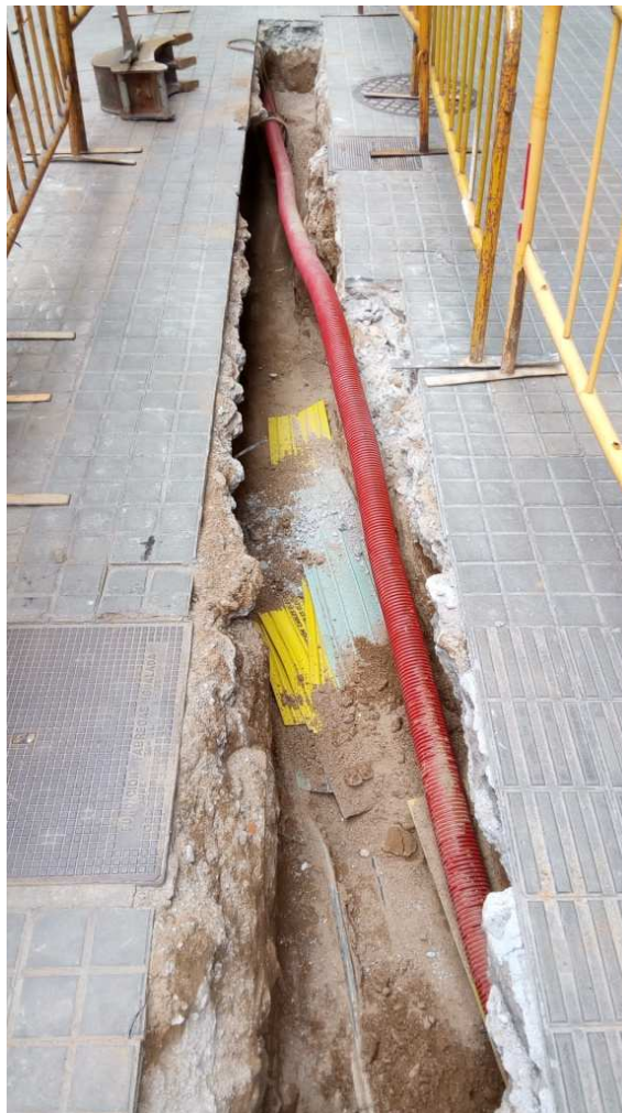
Imatge de la rasa al tram de la rambla Brasil.
